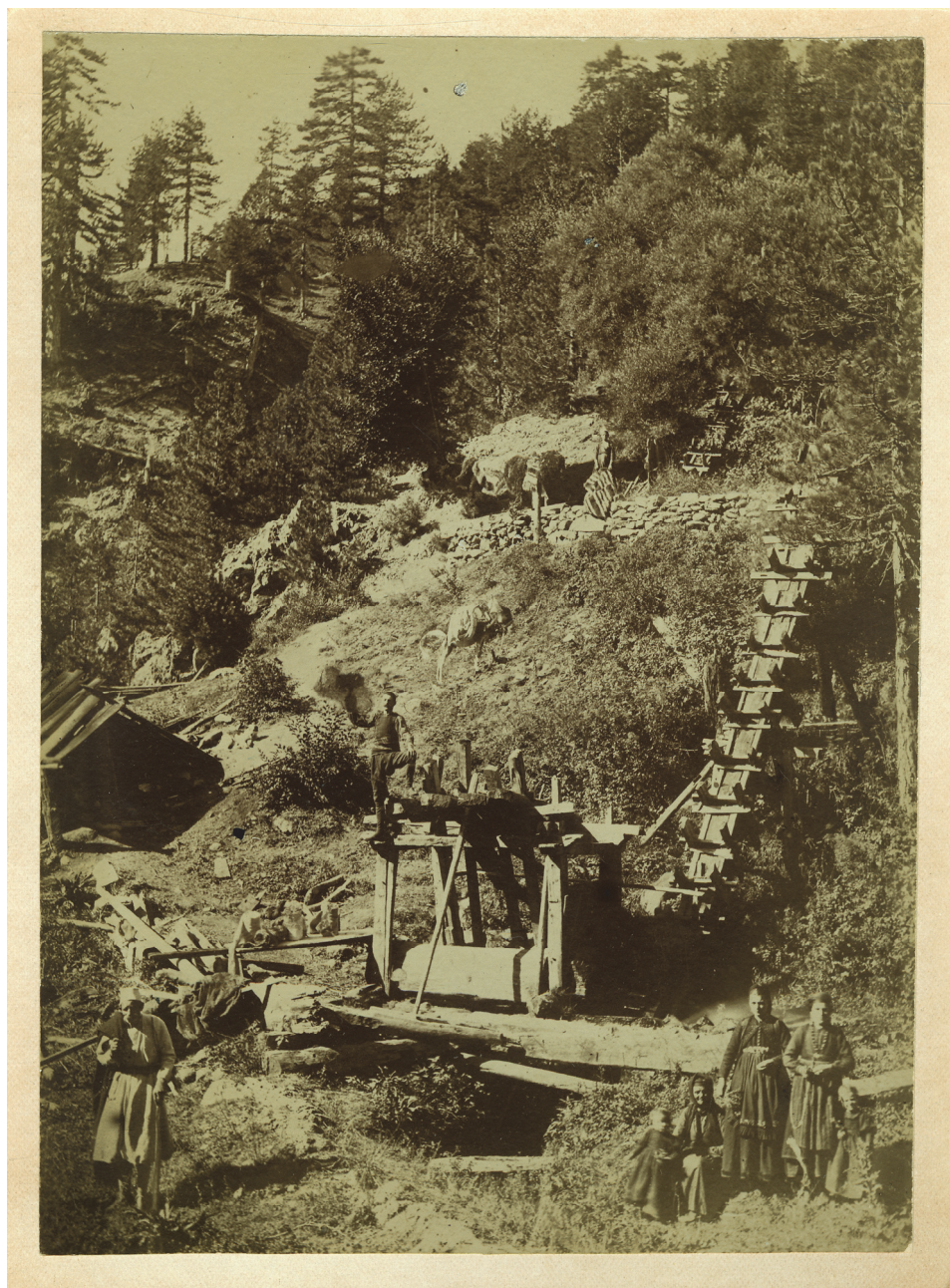
Fig. 10 – Moulin à foulon ( bătal'e ) près de Băiasa, 1927 (fonds photo Manakia, BAR – Bucarest, 44975)
